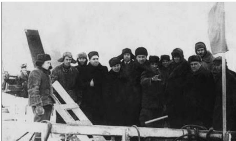
Закладка фундамента доменной печи № 1. 29 ноября 1951 г.
