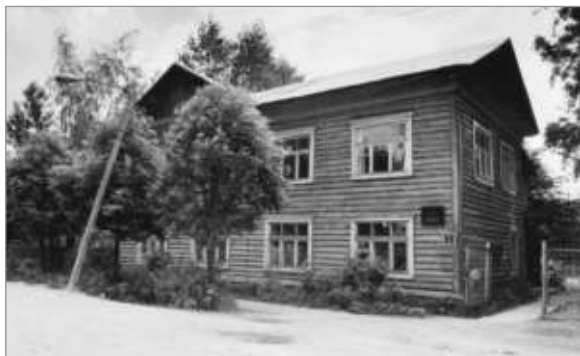
Управление строящегося в 1940-1941 гг. Череповецкого металлургического комбината
