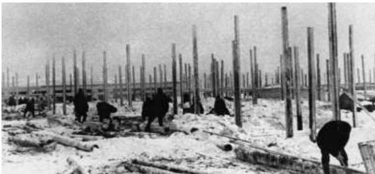
Заключенные «Череповецлага» на строительстве бараков. 1941 г.
