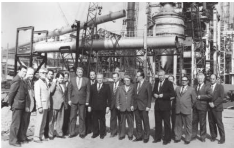
Секретарь ЦК КПСС Б.Н. Ельцин и сопровождающие его лица на строительной площадке ДП-5. Август 1985 г.
