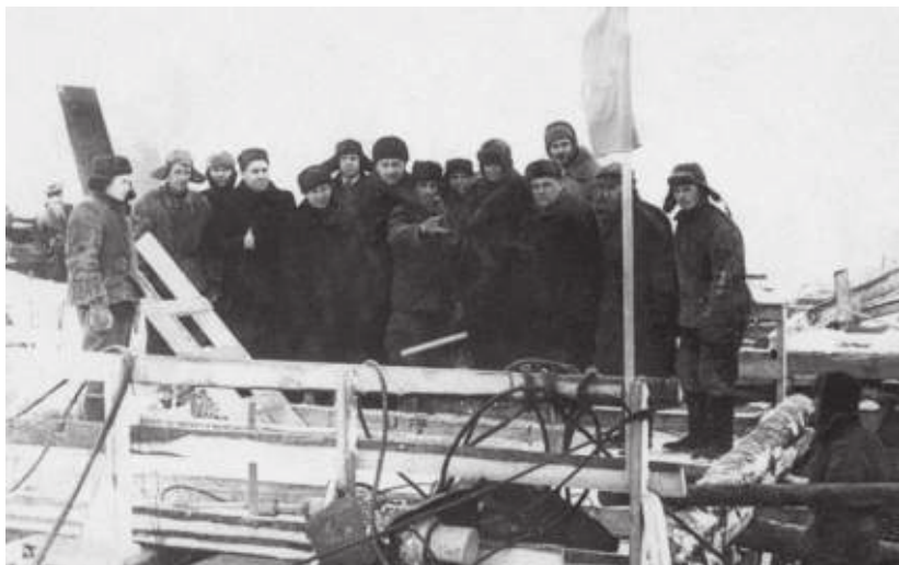
Закладка фундамента доменной печи № 1. 29 ноября 1951 г.
