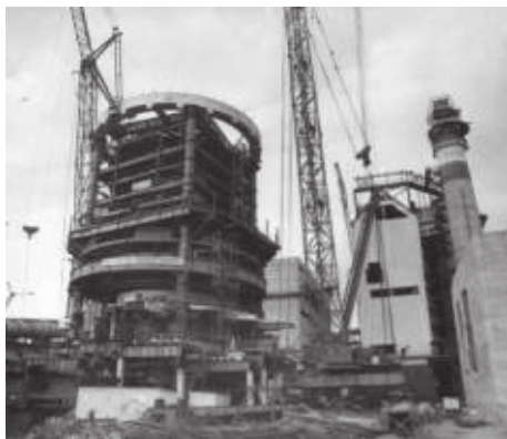
Череповецкая «Северянка» стала главной стройкой СССР
