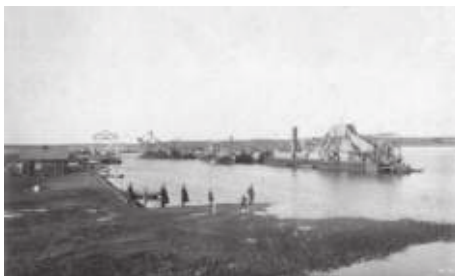
Благодаря Милютину через Череповец прошла Северная железная дорога, построена гавань. Тем самым была заложена прочная основа для будущего экономического развития города
