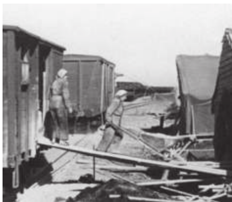
Временные склады строителей
