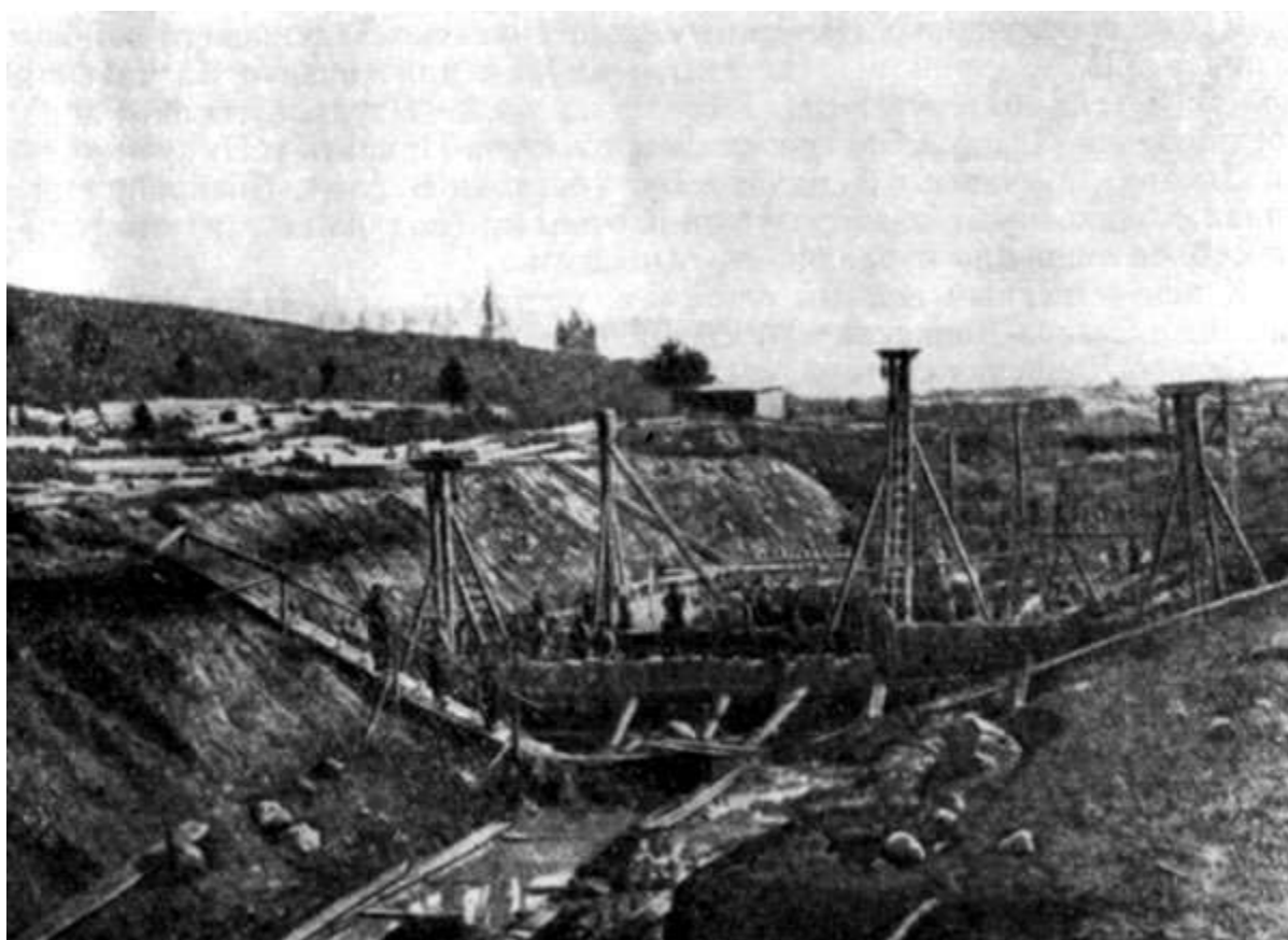
Фото 1. Забивание свай под основание деревянного шлюза при переустройстве Мариинской системы.
